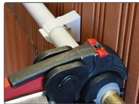
Gebruik van de knijptang zonder demontage van de buis
