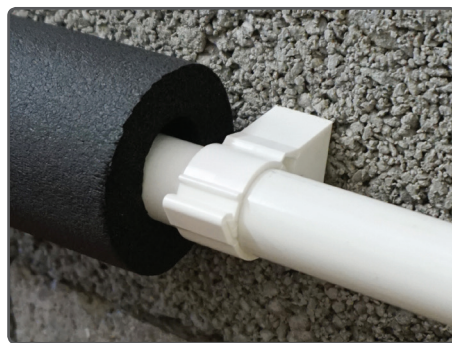
Goede afstand van de muur voor het plaatsen van de isolatie
